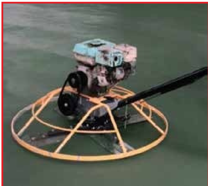
Hình ảnh thi công Munich HF
