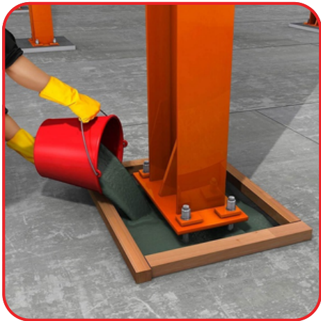
Hình ảnh thi công Munich Grout G-650
